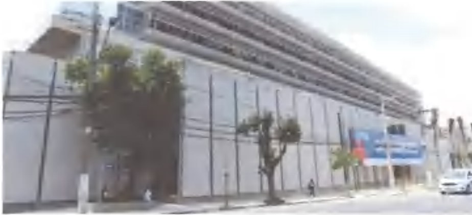
Novo equipamento de Saúde de São Bernardo está com 97% das obras concluídas. Foto: Divulgação/PSDB-Ricardo Cassin
